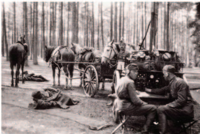
Radiostacja RKD podczas pracy.
